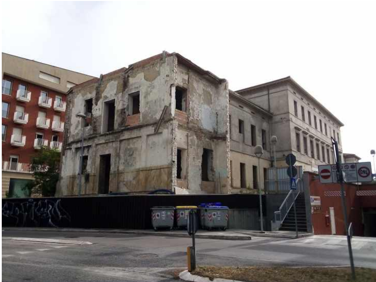
Vista del cantiere dalla pubblica via – Agosto 2024
